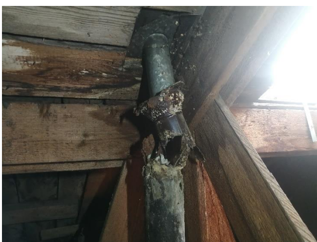
5) poškozená ventilační trubka
