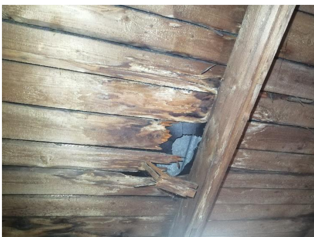
3) poškozené plné prkenné bednění
